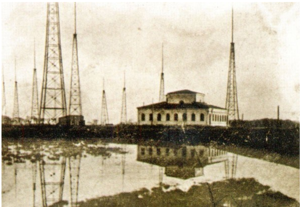
Os suportes 75 metros dipolos apoio de treliça de altura para Ondalunga de mais de 1200 metros
