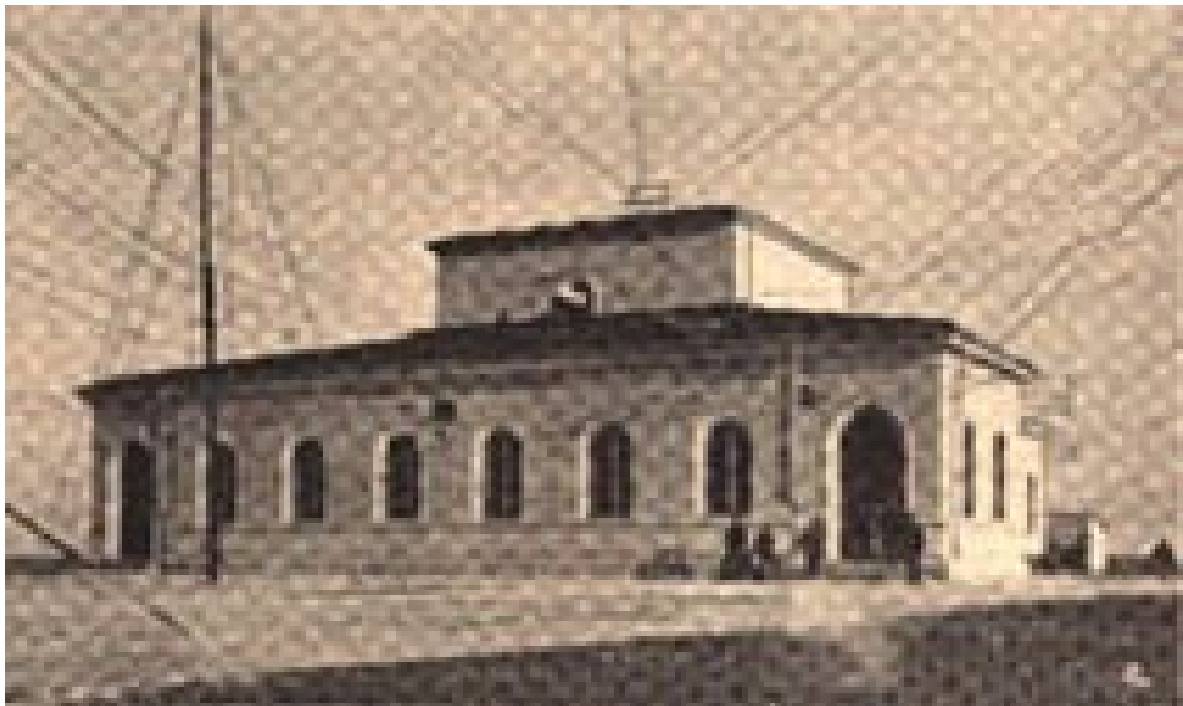
Otra perspectiva de la sede de la estación de radio Marconi Palazzina
