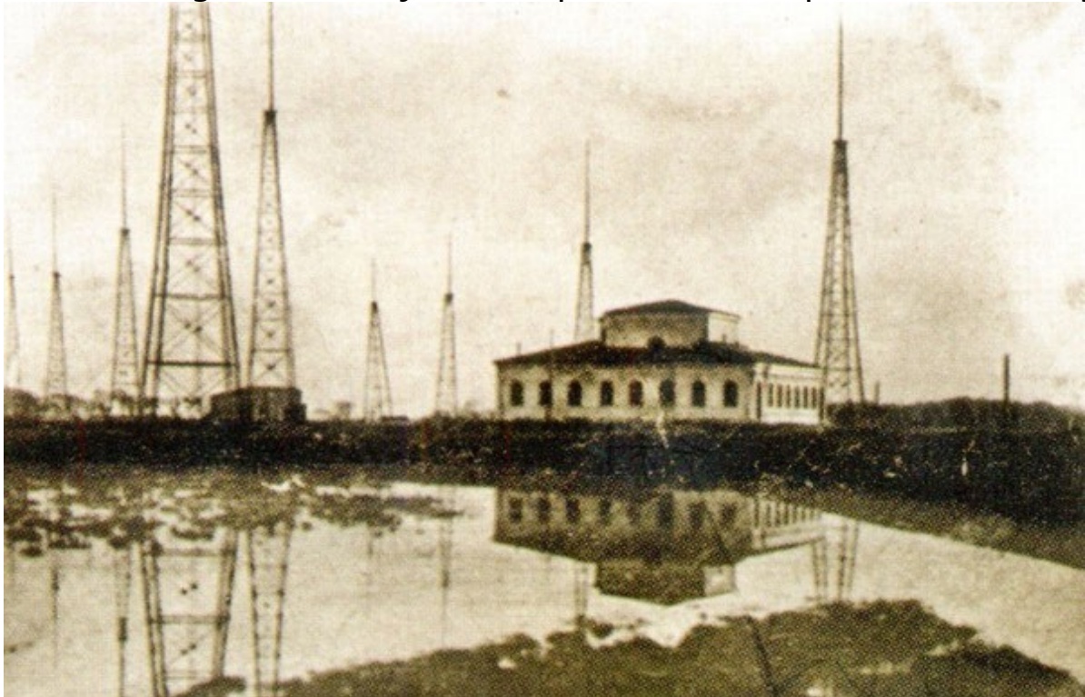
Los soportes 75 metros de altura dipolos de apoyo de celosía para Ondalunga de más de 1200 metros
