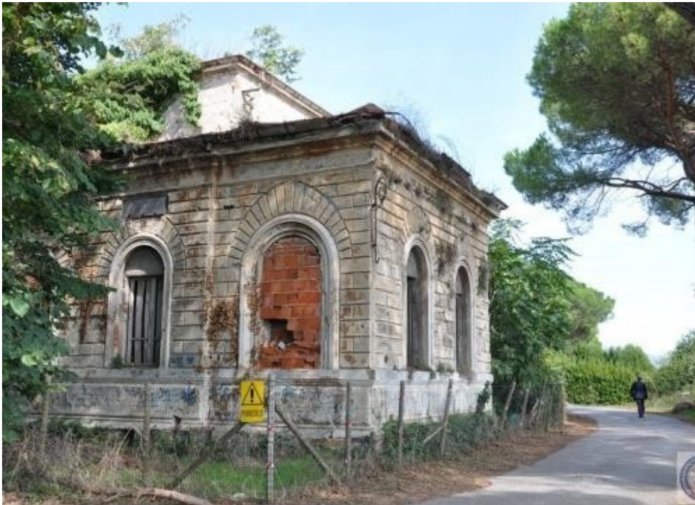
La obra de construcción de la 1ª Estación radiotelegráfica Marconi que hoy
