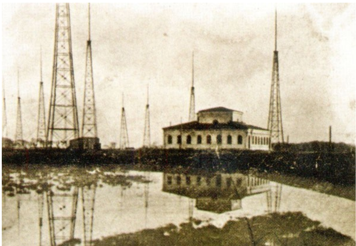
Die Stützen 75 Meter hohen Gitterträger Dipole für Ondalunga von über 1200 Meter
