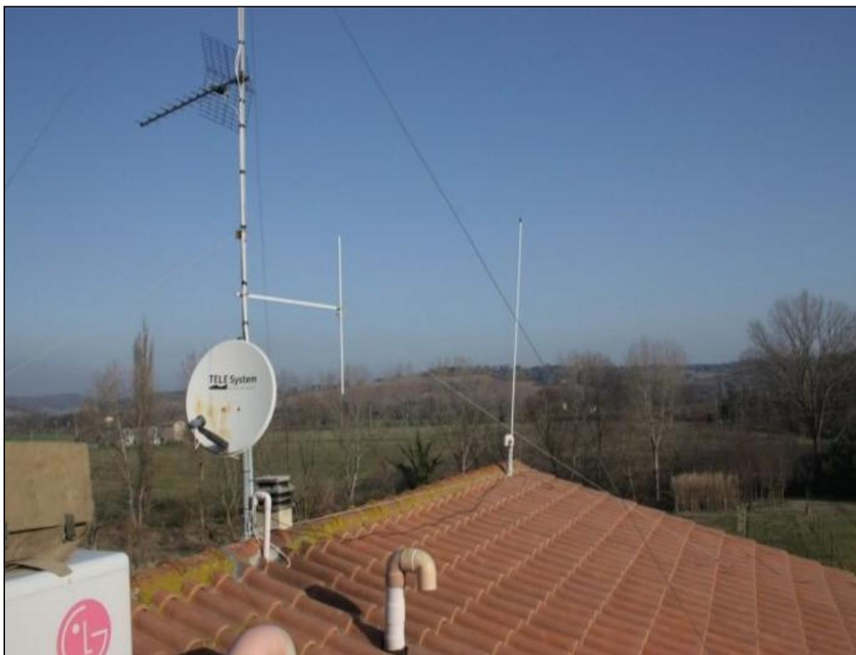
Supponiamo che queste antenne non siano collegate a terra. Essendo l'edificio isolato la probabilità che il fulmine possa colpire la struttura è più alta rispetto al solito edificio inserito nel contesto urbano.
